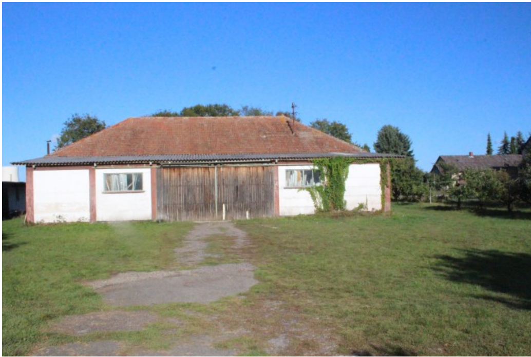
Abbildung 3: Südliches Flurstück Nr. 2672 mit Lagerhalle von Westen
